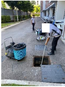
ภาพที่ 2-13 การตักไขมันและน้ำมันออกจากถังดักไขมัน
