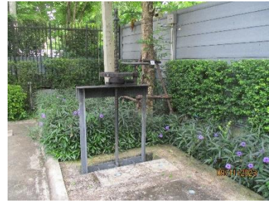
ภาพที่ 2-19 ตู้ควบคุมการระบายน้ำและบ่อหน่วงน้ำของโครงการ
