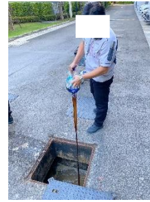
ภาพที่ 2-13 การตักไขมันและน้ำมันออกจากถังดักไขมัน
