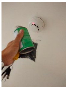
ภาพที่ 2-44 การตรวจสอบระบบป้องกันเตือนอัคคีภัย
